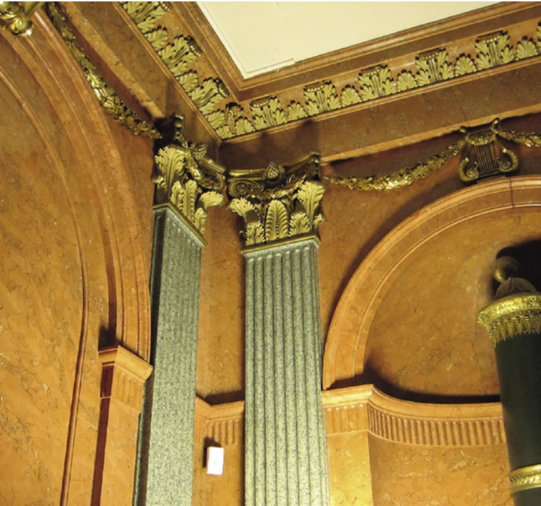
Wanden voorzien van stucmarmor in verschillende kleuren
