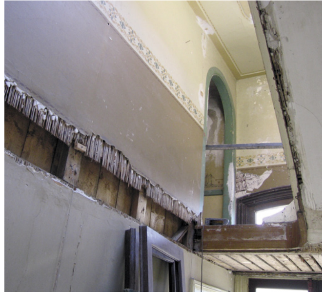
Riet op het houten raamwerk van een scheidingswand draagt hier het stucwerk
