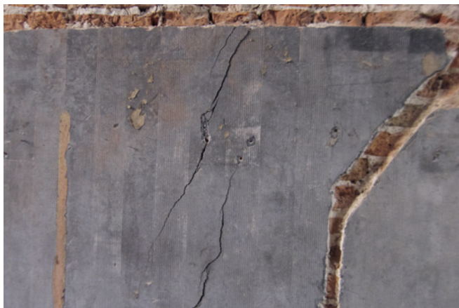
In zeldzaam, gekleurd stucwerk met een frijnslag om de uitstraling van hardsteen te krijgen is een installateur een leiding aan gaan leggen
