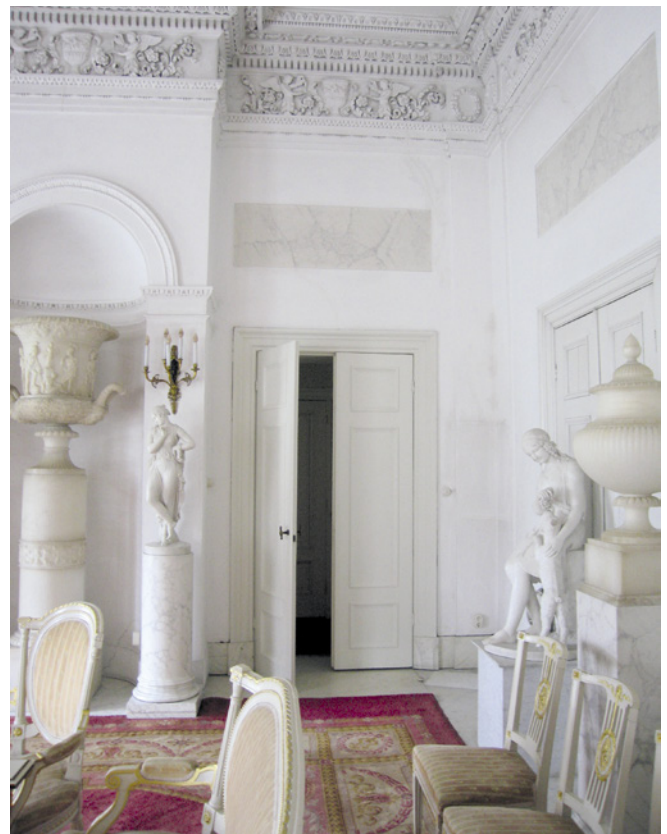
Wanden met stucco lustro, een marmerimitatie op een pleisterlaag van kalkmortel
