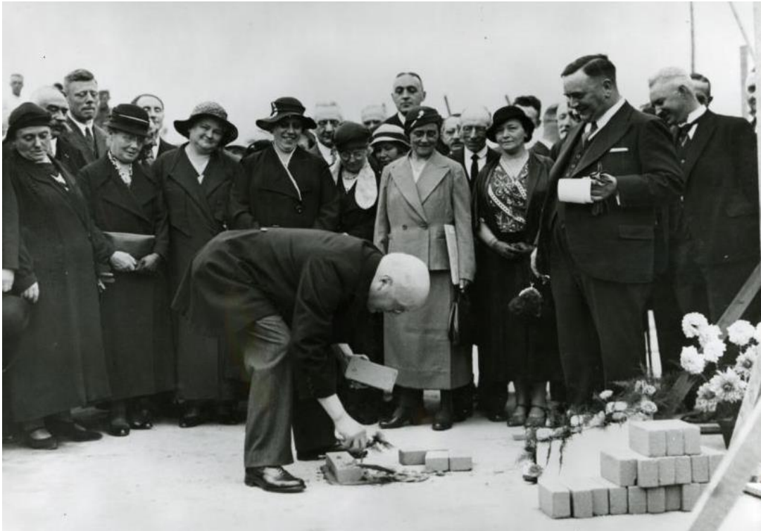
Op deze foto is te zien hoe burgemeester H. Stulemeyer in 1933 de eerste steen legde van het nieuwe sint Jacobsgasthuis aan de Burgemeester Knappert-laan. Het huis aan de Hoogstraat voldeed niet meer aan de eisen van toen en dus besloot men tot de bouw van een nieuw gasthuis. De vrouw in de lichte kledij is mevrouw Koeten-Ooms. 102
